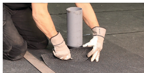
6. Skär ut för stosen. Var försiktig så att inte stosen skadas.
