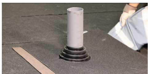
7. Snedskär hörnen. Lossa resterande del av releasefilmen.
