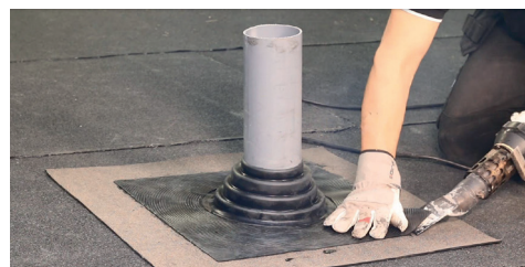
3. Svetsa fast stosen i intäckningskragen.
