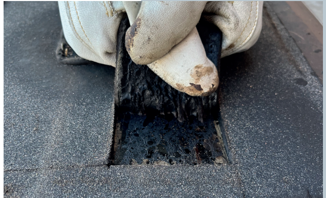
Vidhäftning kontrolleras genom att bitumentrådar uppstår, och att remsan inte kan lossas med handkraft.
