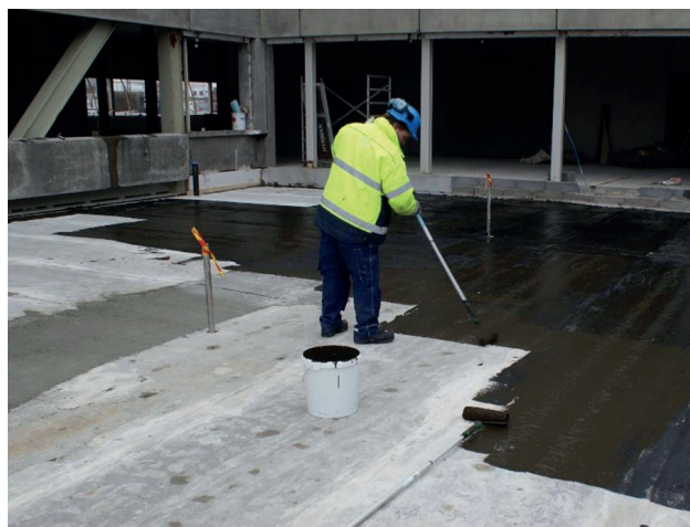
Strykning av ytan med primer. Beroende på underlagets beskaffenhet kan denna process få utföras i flera omgångar för att uppnå full täckning.
