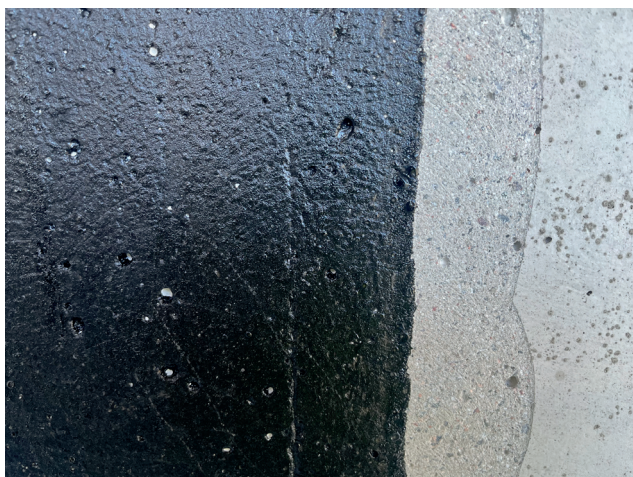
Betong som slipats till porer framträtt. Primer påfört och torkat. Ytterligare primer ska strykas för full täckning.
