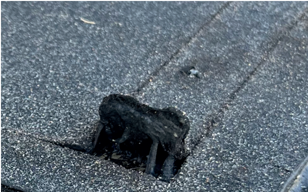
Remsan lossas.
