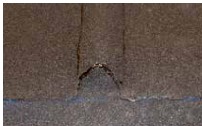
5. Avsluta med att helsvetsa en kappa över listen. Var extra noga med att använda rätt mängd värme för att undvika stora utrinningar av asfalt.
