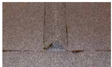
5. Montera Trebolit listtak mellan trekantslisterna.
