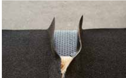
2. Montera Trebolit Listtak mellan trekantstlisterna. Våderna ska mötas på toppen av trekantstlisten.
