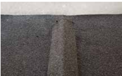
4. Skär ut en remsa av Trebolit Listtak och helsvetsa mot listen.
