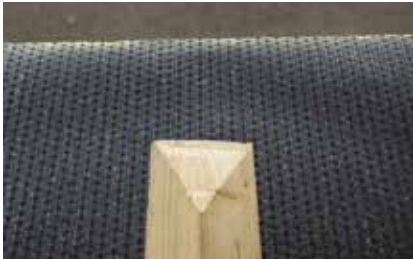
1. Montera trekantslisterna ovanpå underlagstäckningen.
