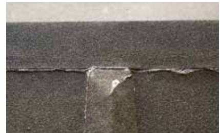
6. Avsluta med att montera nockkappa ned till trekantstlisten.
