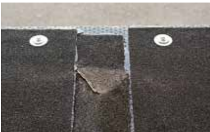
4. Montera Trebolit Listtak mellan listerna. Fäst in mekaniskt i ovankant.
