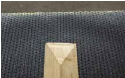
1. Montera trekantslisterna ovanpå underlagstäckningen
