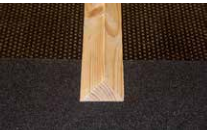
1. Montera lister ovanpå underlagstäckning och fotkappa.
