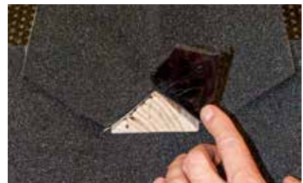
3. Snedskär remsans kanter och skär ut för listavslutet.
