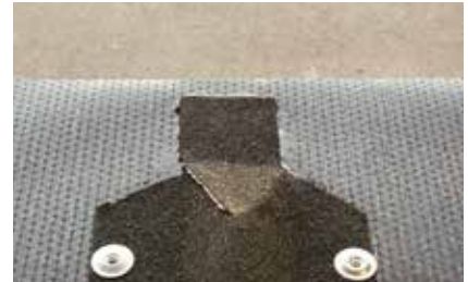
3. Fäst in remsan mekaniskt i underlaget.
