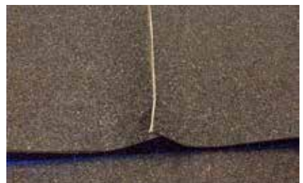
3. Anslut med Trebolit Listtak mellan trekantstlisterna. Våderna ska mötas på toppen av trekantstlisten.
