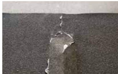
5. Skär till detaljen och svetsa mot listen. Var noga med att använda rätt mängd värme för att undvika stora utrinningar av asfalt.
