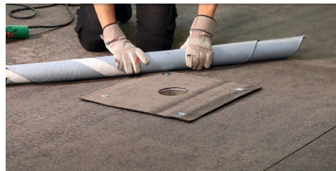
3. Rulla upp rännalsvåden för att komma åt att svetsa.
