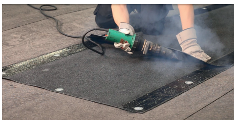
8. Helsvetsa rännalsvådens överlapp. Börja längst in och se till att kapsla in värmen för att uppnå bästa resultat.
