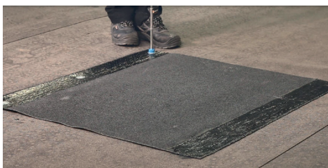
5. Fäst in rännalsvåden mekaniskt.
