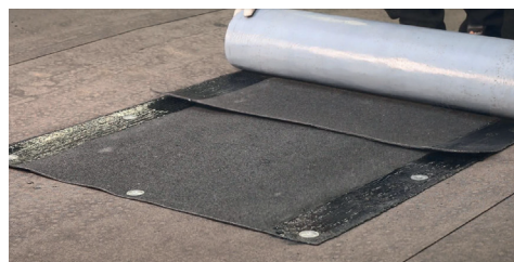
6. Anslut med E-Lit RV. Ta bort releasefilmen i överlappet. Övrig releasefilm kan tas bort vid behov.
