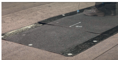
7. Skarvar i rännaldalar ska helsvetsas minst 300 mm. Alternativt förstärks skarvarna med en underliggande remsa av minst kvalitet YEP 3500, B=0,33 m och L=1 m. Den underliggande remsan ska helsvetsas mot de överliggande våderna. Rännalsvåd i anslutning till vertikal ska utformas så att rännalscentrum bildas minst 500 mm från den vertikala ytan.
