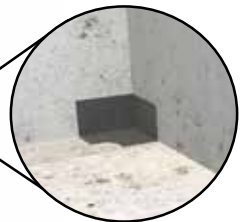
Hörsättningsremsa monteras alltid i in- och utvändiga hörn
