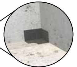
Hörsättningsremsa monteras alltid i in- och utvändiga hörn
