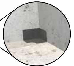
Hörntätningsremsa monteras alltid i in- och utvändiga hörn
