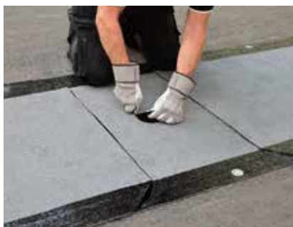
7. Skär ut hålet för brunnen med en varm kniv.
