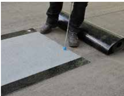
4. Fäst in rännalsvåden mekaniskt i underlaget.
