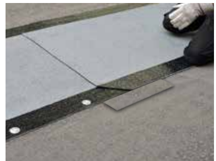
5b. Alternativt förstärks skarvarna med underliggande remsa av minst YEP 3500 0,3 x 1 m.
