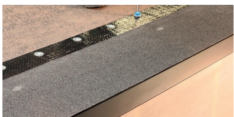
7. Remsan fästs in mekaniskt i underlaget.
