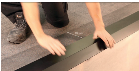
2. Den underliggande remsan ska nå minst 150 mm ovan fotplåtens övre kant.
