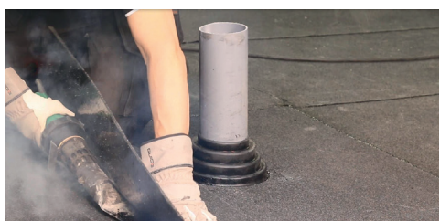
10. Helsvetsa kappan mot underlaget. Börja längst in och se till att kapsla in värmen för att uppnå bästa resultat.
