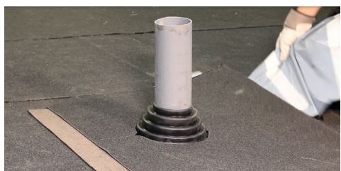
7. Snedskär hörnen. Lossa resterande del av releasefilmen.
