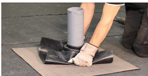
2. Placera stosen och se till att intäckningskragen når minst 100 mm utanför stosen åt alla håll. Värm fast stosen i den underliggande intäckningskragen.
