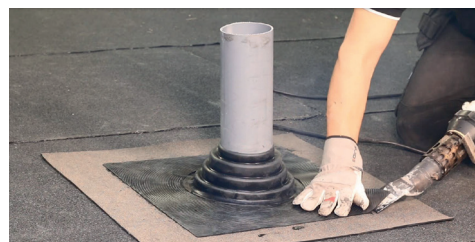
3. Svetsa fast stosen i intäckningskragen.
