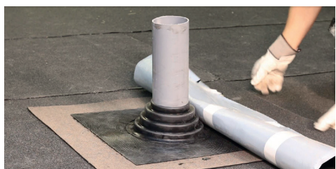
4. Påbörja intäckningen nedifrån med en kapp av E-Lit LA. Arbeta alltid nedifrån takfallets riktning och upp.
