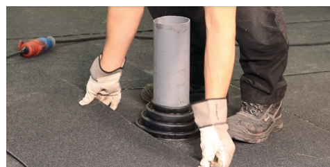
9. Placera den övre delen av kappan så den linjerar med stosens övre sida och dra bort releasefilmen.
